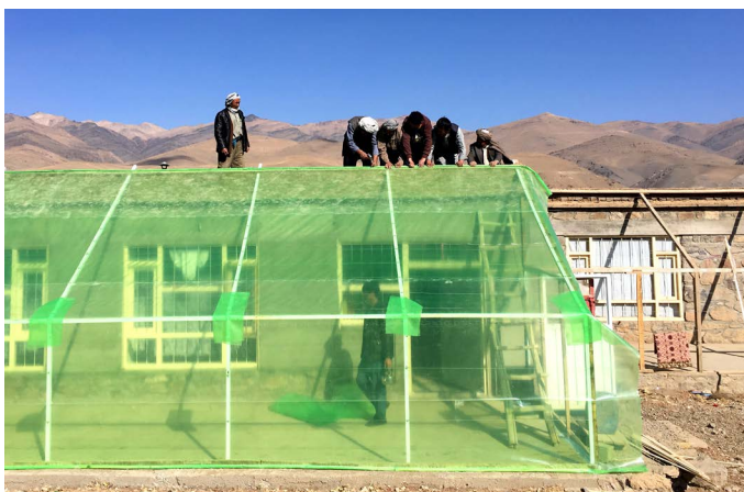
Construction d'une véranda solaire à Behsud
