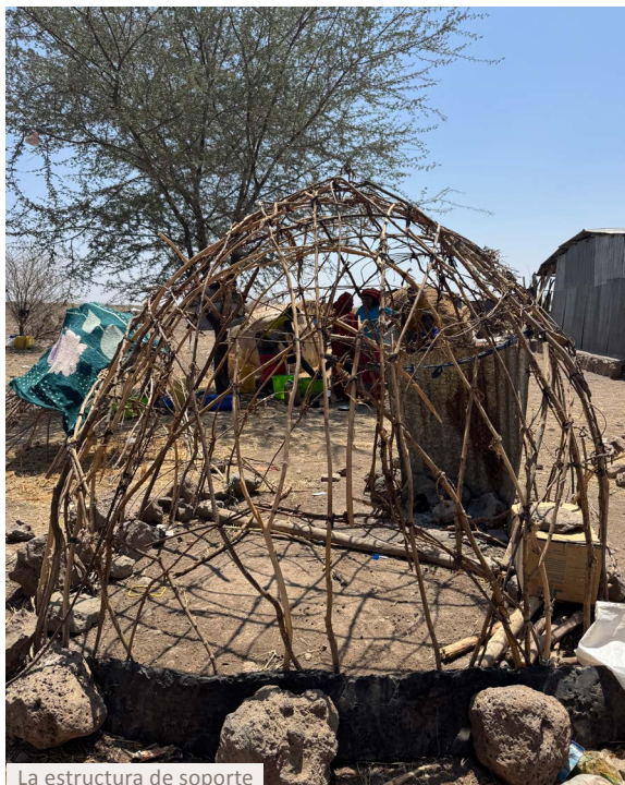
La estructura de soporte de los alojamientos Afar construidos con postes Halawa locales
