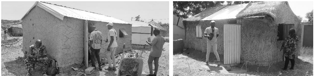
Processus de construction d'abris contextuels à Tibga, région Est (CRS). Cette phase de construction de prototypes a été possible grâce au financement du projet Tin Taani de CRS et a servi à tester les Lignes Directrices:
