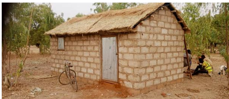
Abri transitoire avec murs en parpaings et toiture en chaume réalisé lors d'une formation des artisans locaux à Tibga région du Goulmou (© Ephrem ILBOUDO-CRS)
