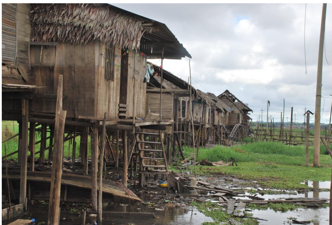
Figura 1: Habituales daños provocados por inundaciones en los barrios semi-urbanos de Punchana, Iquitos
