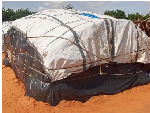
Abri renforcé avec des attaches en palmier doum
