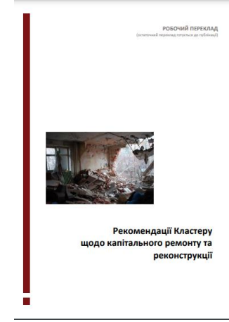
5. Рекомендації Кластера щодо капітального ремонту та реконструкції
