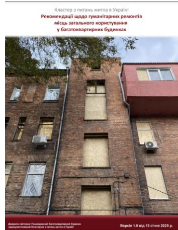
3. Рекомендації щодо гуманітарних ремонтів місць загального користування у багатоквартирних будинках
