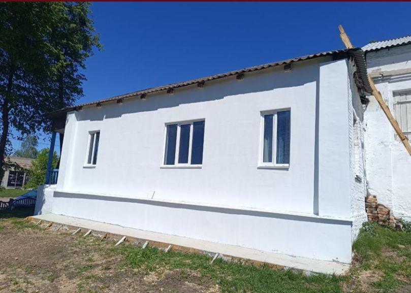
DRC, після реалізації ремонту
