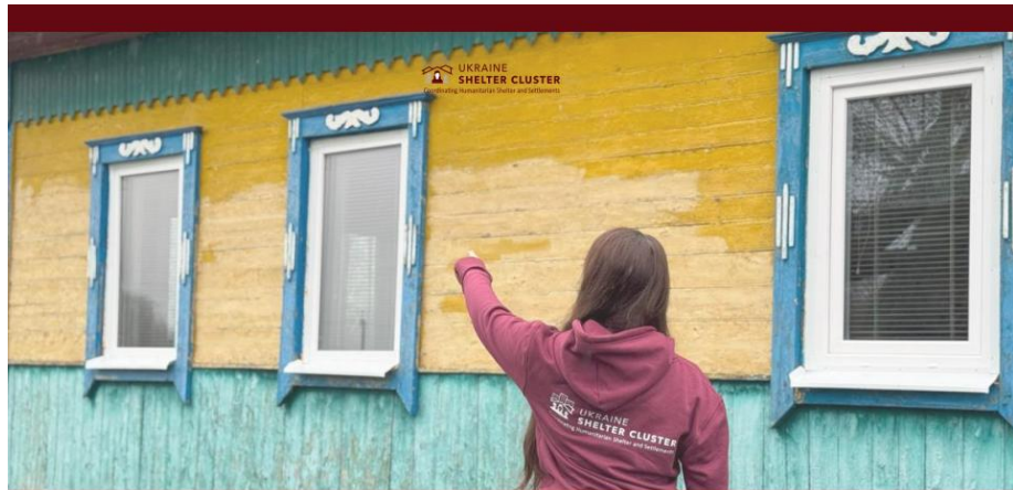
МОНІТОРИНГОВИЙ ВІЗИТ КЛАСТЕРУ З ПИТАНЬ ЖИТЛА ТА НПТ В УКРАЇНІ щодо утеплення будинків, які не відповідають визначеним гуманітарним стандартам та гуманітарні ремонти об'єктів соціальної інфраструктури у Чернігівську область, 2-3 квітня 2025 року
