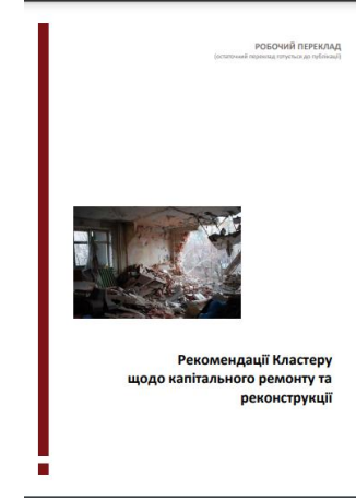
5. Рекомендації Кластера щодо капітального ремонту та реконструкції
