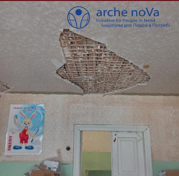
Фото до реалізації ремонту соціальної інфраструктури
