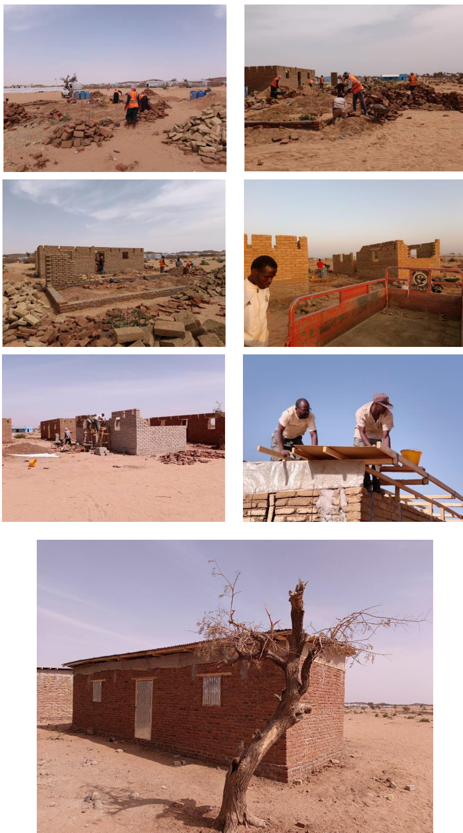
Fig 9, 10, 11, 12, 13, 14 et 15 – Photos illustrant la construction des cinq (5) derniers prototypes finaux d'abris, dans le camp de réfugiés de Farchana, entre janvier et mars 2025.
