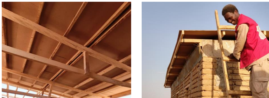
Fig 25 and 26 – Les panneaux SAM pré-découpés à leur arrivée sur le site de construction (25), et leur assemblage sur la structure de toiture (26), selon une stratégie à double couche visant à éviter les infiltrations d'eau.
