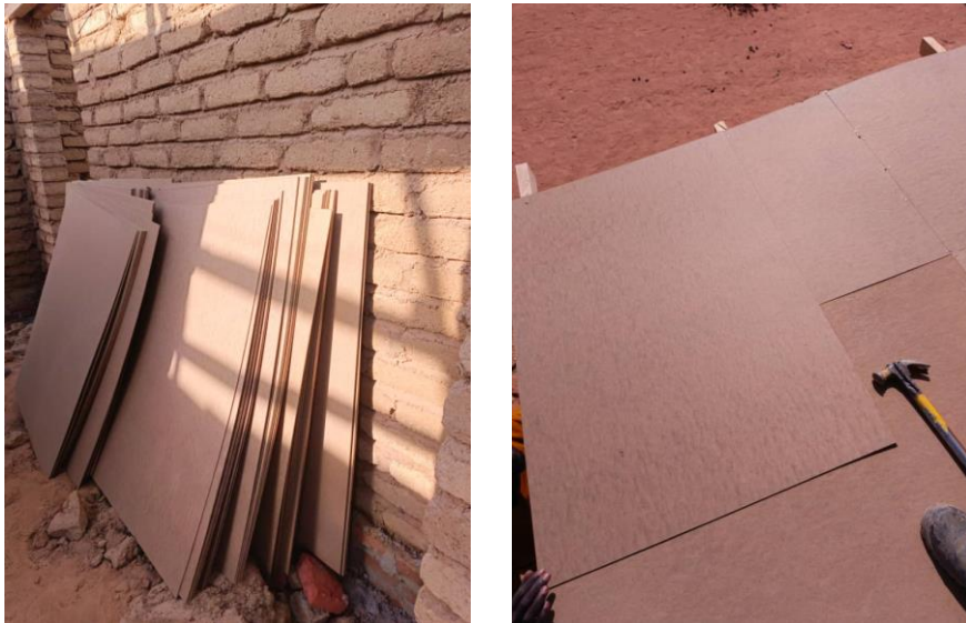
Fig 25 and 26 – Les panneaux SAM pré-découpés à leur arrivée sur le site de construction (25), et leur assemblage sur la structure de toiture (26), selon une stratégie à double couche visant à éviter les infiltrations d'eau.
