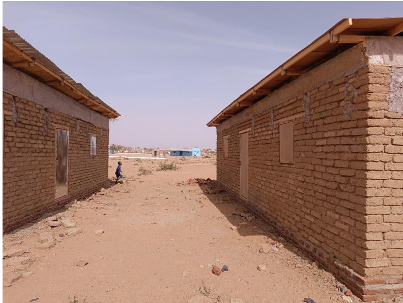
Fig 27, 28 et 29 – Les panneaux SAM utilisés comme solution de toiture pour l'un des abris de test finaux (27 et 28), et comme portes et volets de fenêtres, en contraste avec les tôles ondulées conventionnelles (CGI) (29).
