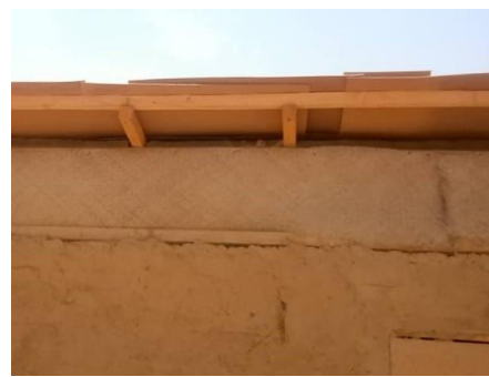
Fig 30 et 31 – Les panneaux SAM après quelques jours de fortes pluies, fin juillet 2025, durant lesquels ils ont montré une légère déformation temporaire, sans toutefois présenter d'infiltrations.
