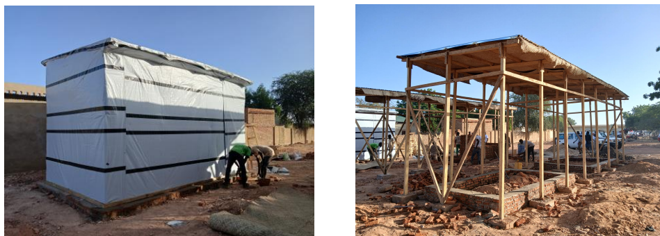
Fig 7 et 8 – Les trois abris de test évalués, encore en cours de finalisation lors de la mission sur le terrain, en novembre 2024.
