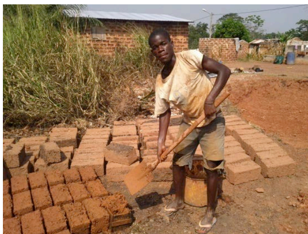
Projet abris de Solidarités, village de Niambly, Département de Doékoué
