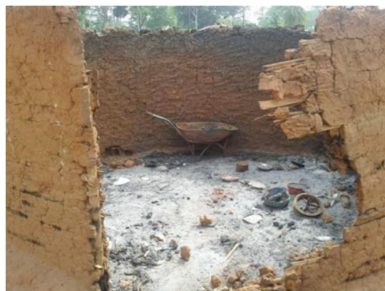
Maison en terre endommagé en février 2012, près de Bangolo, Département de Bangolo
