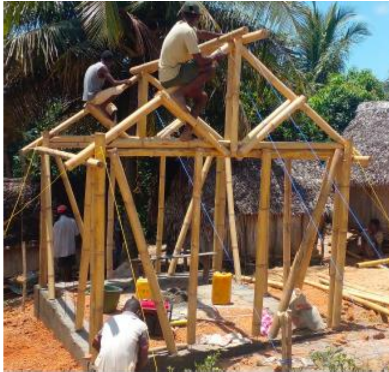
Formation de charpentiers
