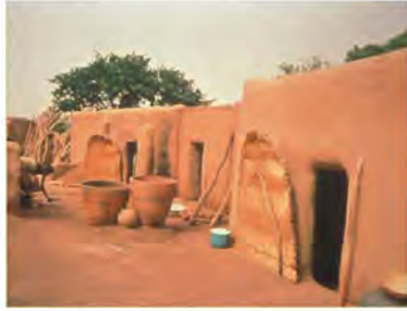
Maison en adobe, Burkina faso
