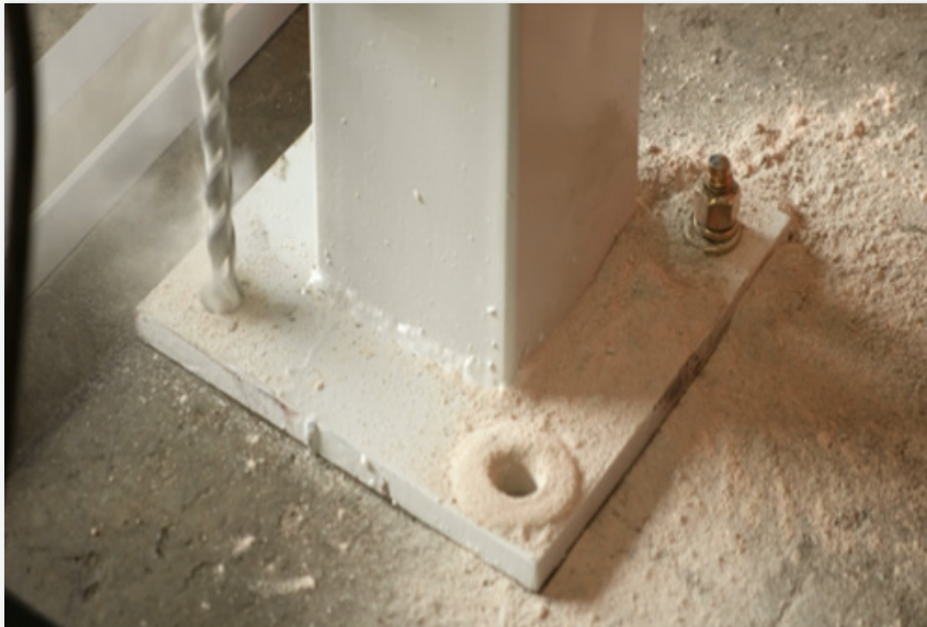
Pekerjaan Pengeboran Lubang Plat Kolom Struktur
