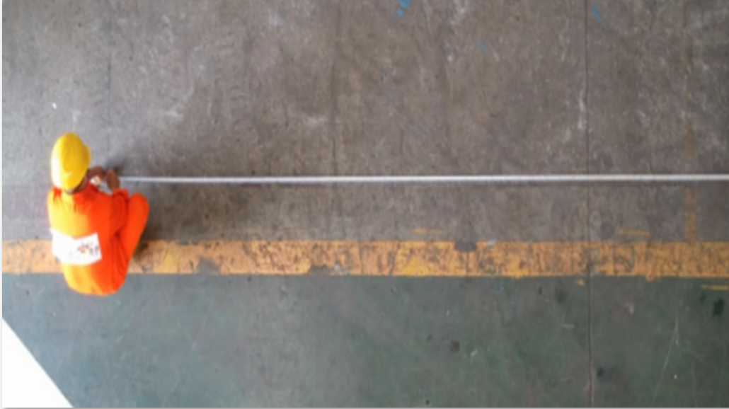
Pekerjaan Pengukuran dan Penandaan Garis Bangunan
