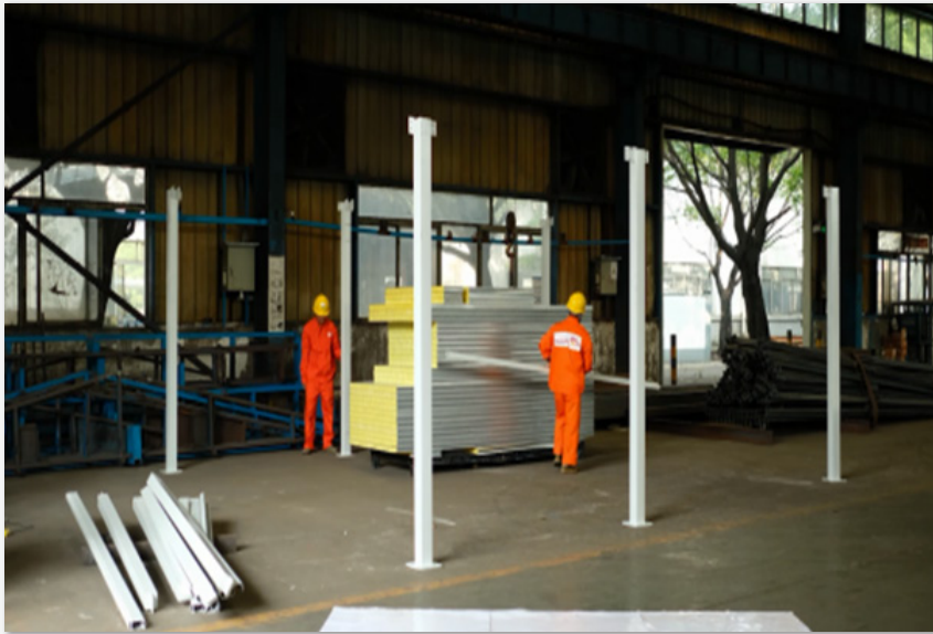
Pemasangan 6 Buah Kolom Struktur
