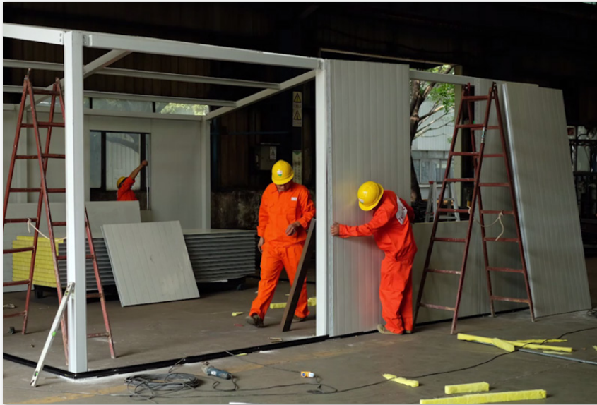
Pemasangan Lembar Dinding Penutup pada Landasan Baja C
