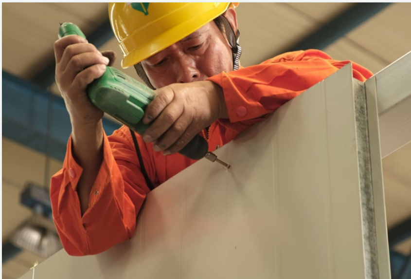
Pemasangan Lembar Dinding Penutup pada Balok Struktur
