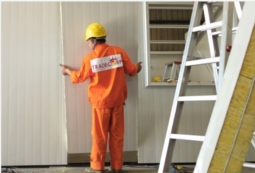
Pemasangan kusen pintu dan daun pintu
