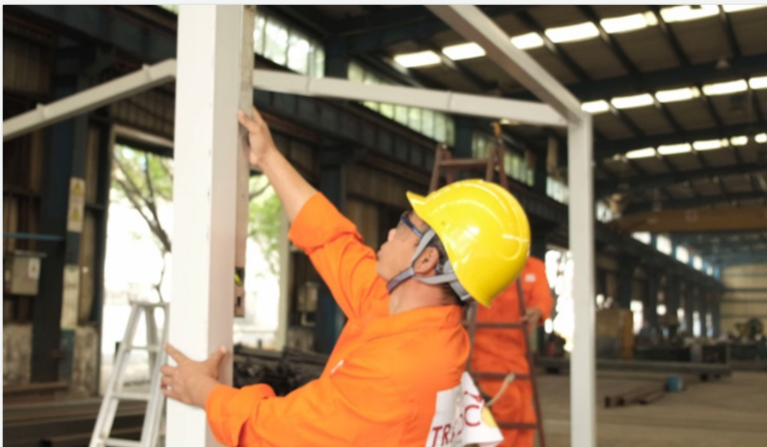
Pengecekan Kelurusan Vertikal Struktur Bangunan
