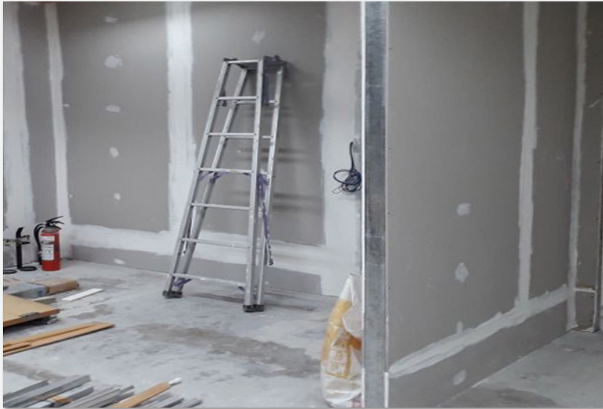
Pemasangan partisi gypsum ruang kamar
