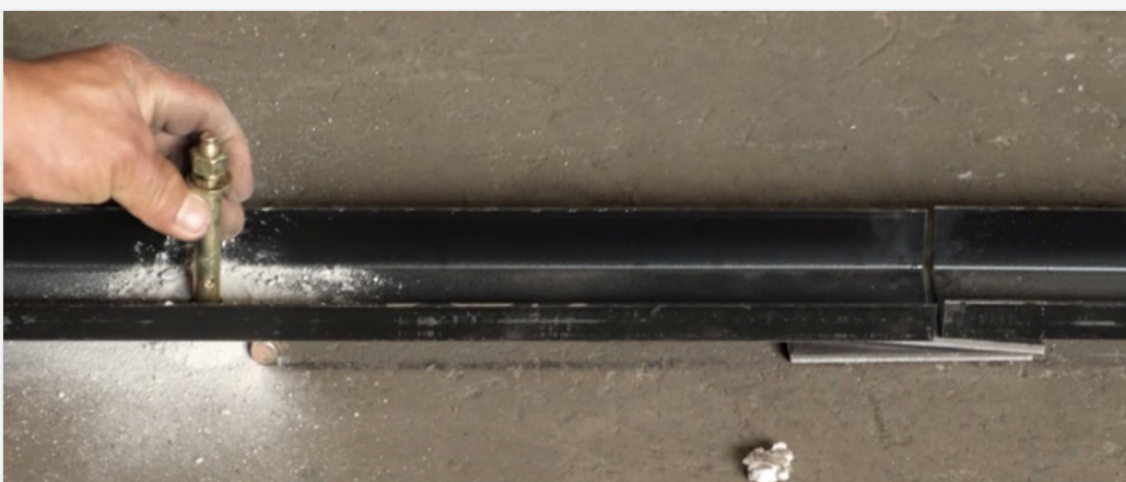
Pemasangan Baut pada Landasan Baja C
