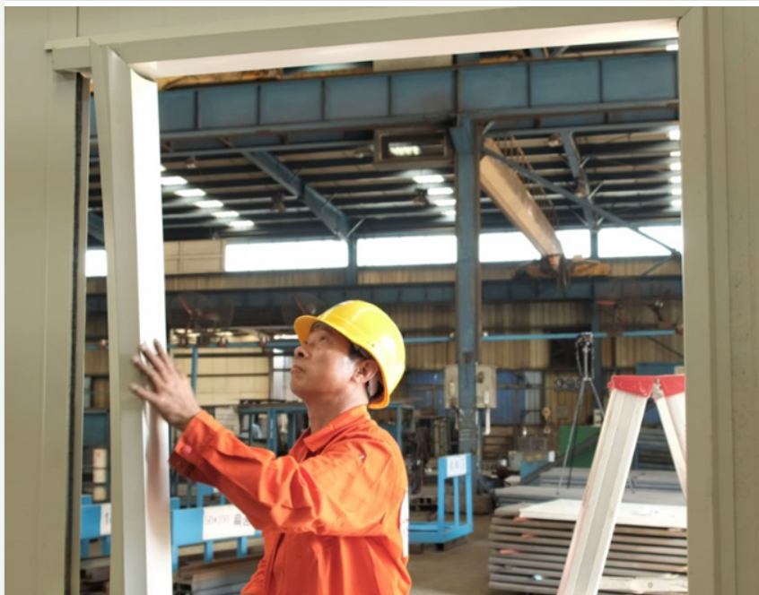
Pemasangan Kusen Jendela
