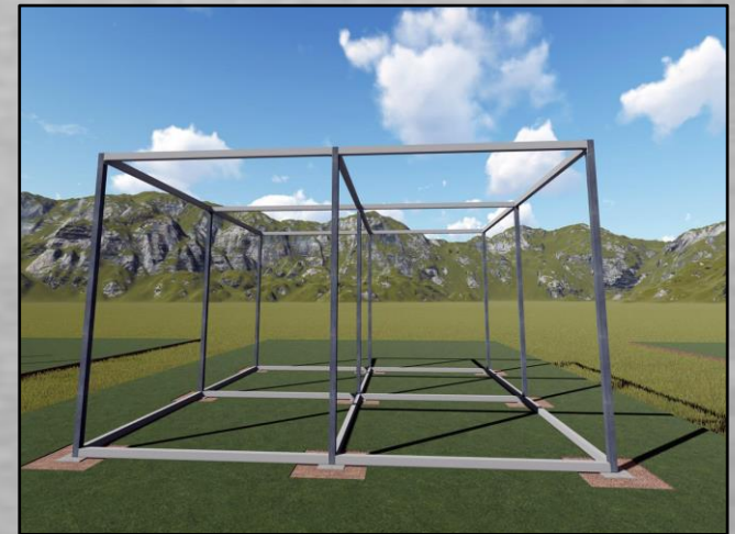
Pemasangan rangka balok 60x40x1.8mm
