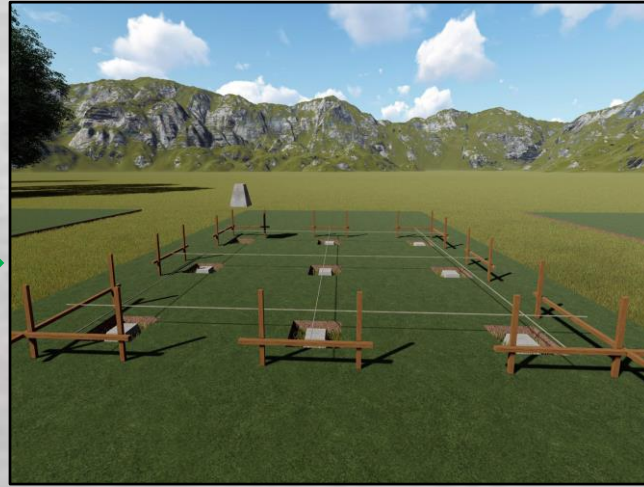
Pemasangan pondasi setempat yang sudah di cetak
