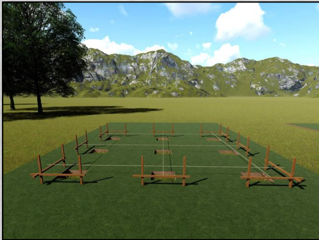
Pekerjaan pengukuran, bouwplank dan galian titik pondasi
