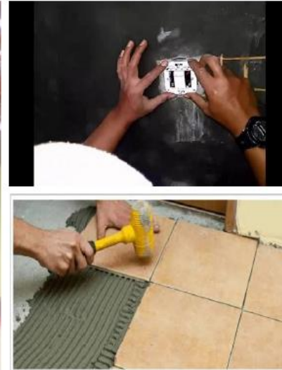
Pemasangan Keramik dan Listrik
