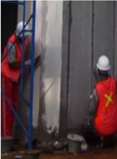
Pendempulan Sambungan dinding
