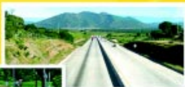
CONCRETO HIDRÁULICO Calle de Interconexión Apopa- Nejapa-Bvd. Constitución
