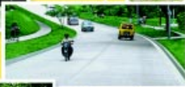
CONCRETO HIDRÁULICO CON SISTEMA DE MOLDE FIJO Apopa
