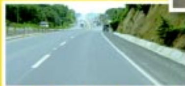
CONCRETO COMPACTADO CON PAVIMENTADORA O RODILLO Calle San Martín-San Rafael Cedros
