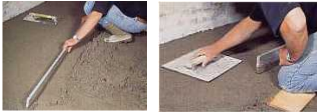
b) Alisado del concreto con regla y con llana
