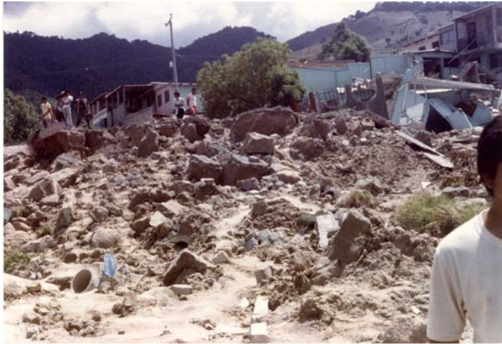
Foto 5: Daños sufridos por viviendas, sin confinamiento, construidas a media ladera, al desplazarse el terreno durante un sismo.
