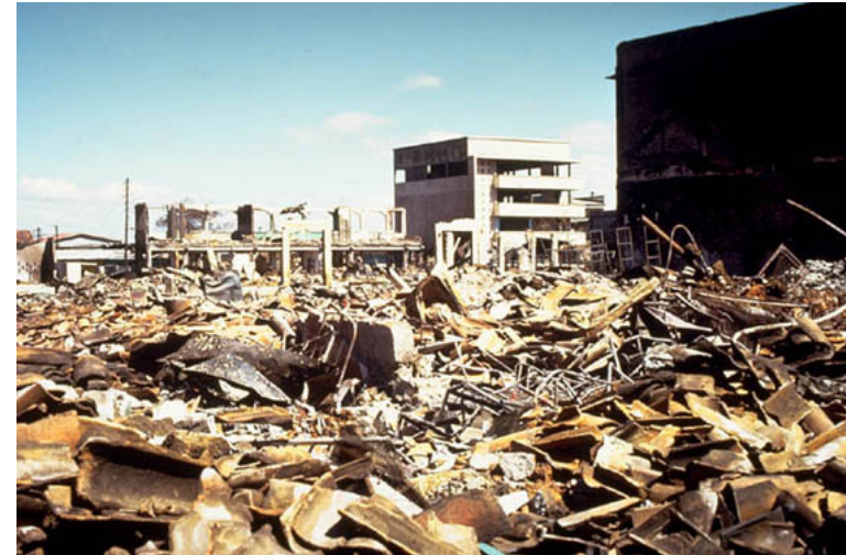
Foto 6: Daños sufridos por viviendas construidas en mampostería no reforzada ni confinada (Managua 1972)
