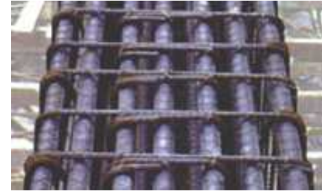
Detalle de armado de una viga, en la cual se observan los diferentes diámetros de cabilla utilizados en el acero longitudinal y los estribos
