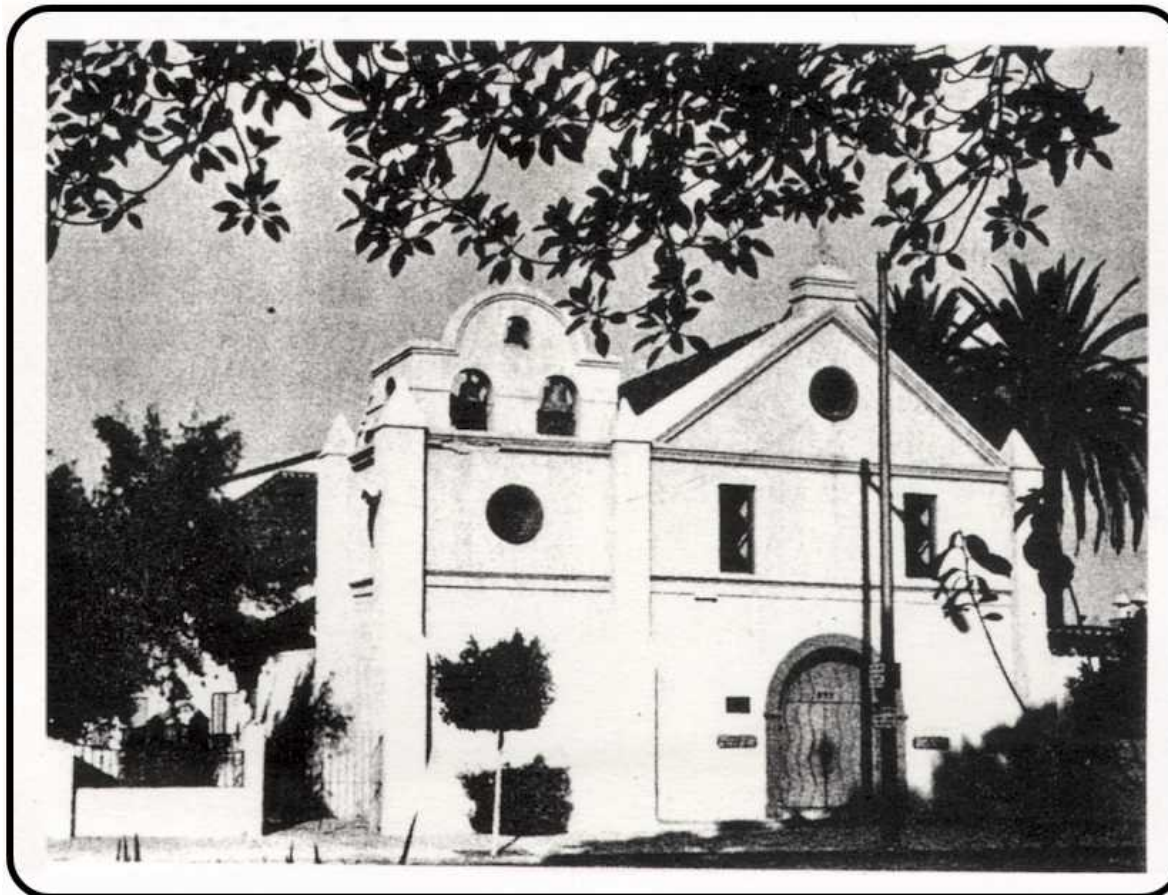
Iglesia de Nuestra Señora La Reina de Los Ángeles, una iglesia construida en Adobe en la plaza de La Puebla, al centro de la actual ciudad de Los Ángeles
