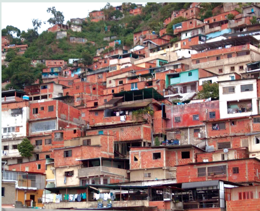
Figura 25 Edificaciones de mampostería en la ciudad de Caracas
