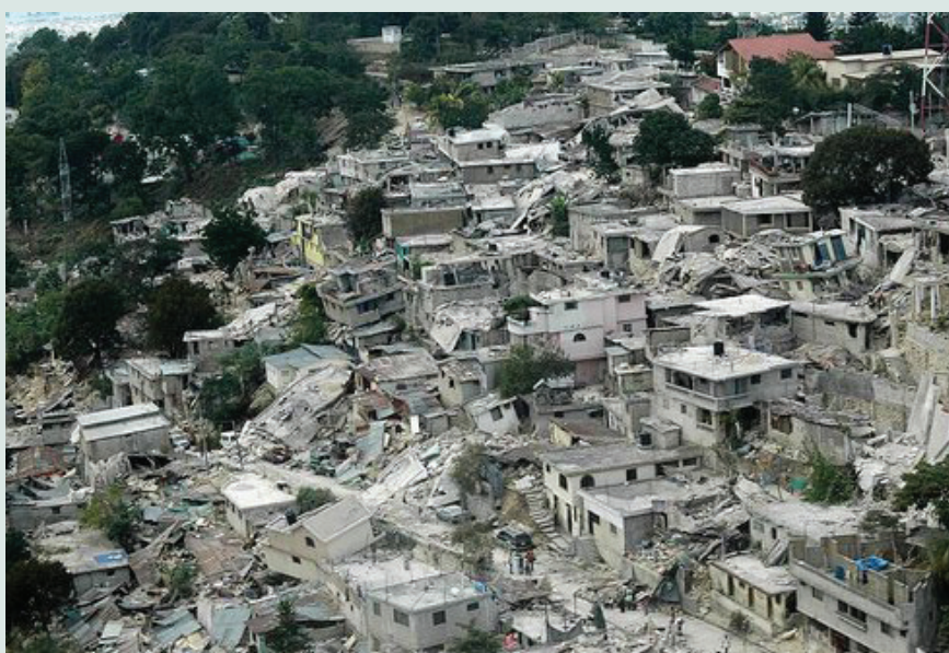
Figura 26 Edificaciones de mampostería dañadas por el terremoto ocurrido en Haití en 2010
