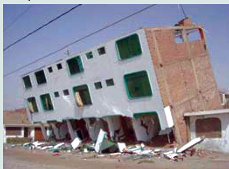
Ausencia de muros en una dirección en la planta baja
