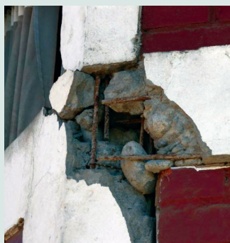
Acero de refuerzo insuficiente y mal detallado
