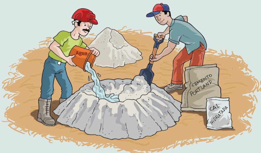
Figura 11 Dosificación y preparación del mortero
