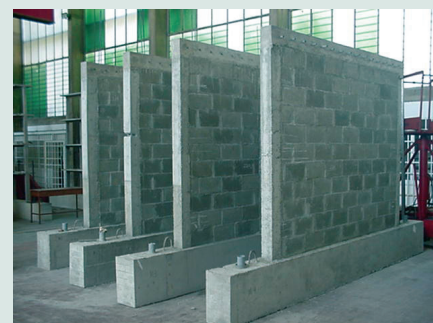
Muros de mampostería confinada terminados
