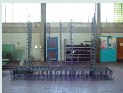
Armado de la viga de fundación y anclaje del refuerzo longitudinal de los machones
