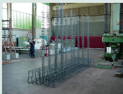
Armado de la viga de fundación y anclaje del refuerzo longitudinal de los machones
