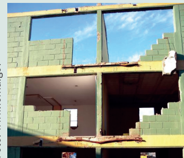
Falta de elementos confinantes alrededor de las aberturas
