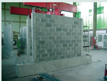
Vaciado del concreto de los machones
