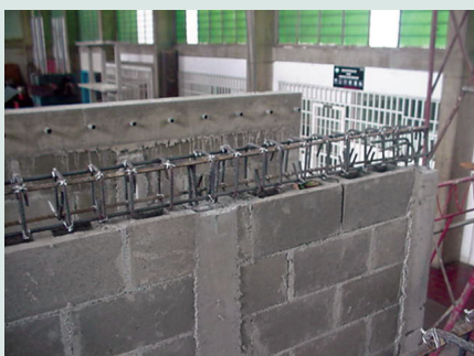
Colocación del armado de la viga de corona
