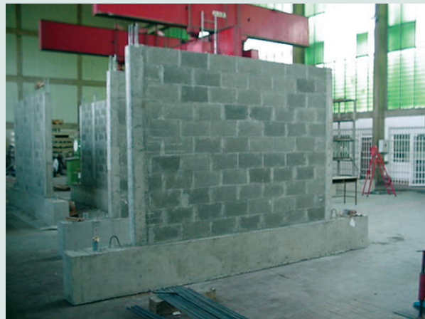
Figura 8 Luego se vacían los machones y la viga de corona
