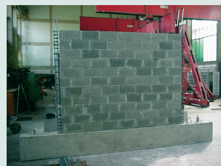
Fabricación de la pared de mampostería y colocación y armado de machones
