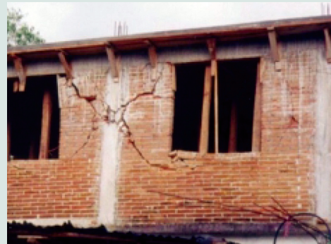
Ausencia de suficientes elementos de confinamiento
