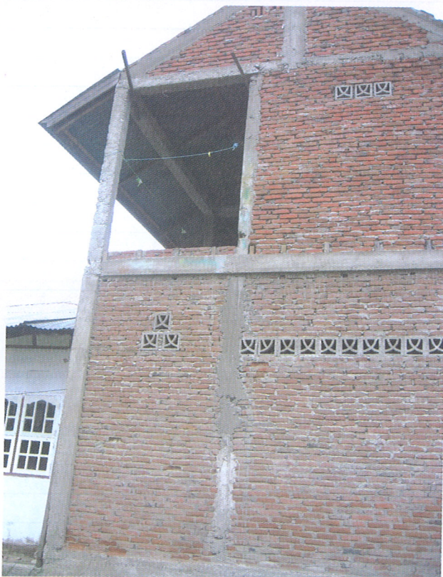
Rumah ini merupakan contoh buruk untuk kualitas konstruksi beton
