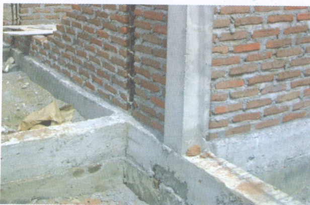
contoh yang lebih baik pengerjaan beton
