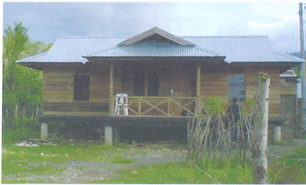
Bangunan rumah dengan kerangka kayu ini ditopang langsung oleh kolom-kolom beton.
