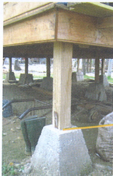
Bangunan rumah dengan kerangka kayu ini ditopang langsung oleh kolom-kolom beton.
