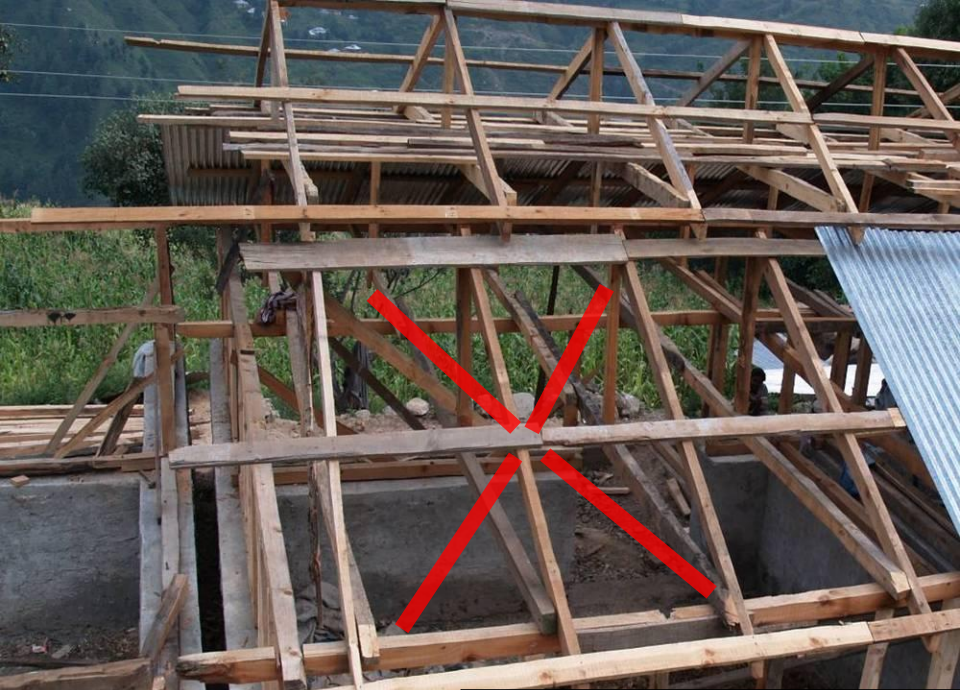
Le contreventement dans le plan du toit
