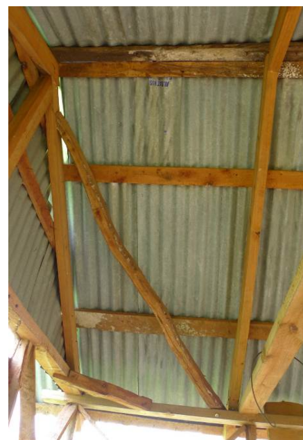
Type de contreventement traditionnel en Haïti
