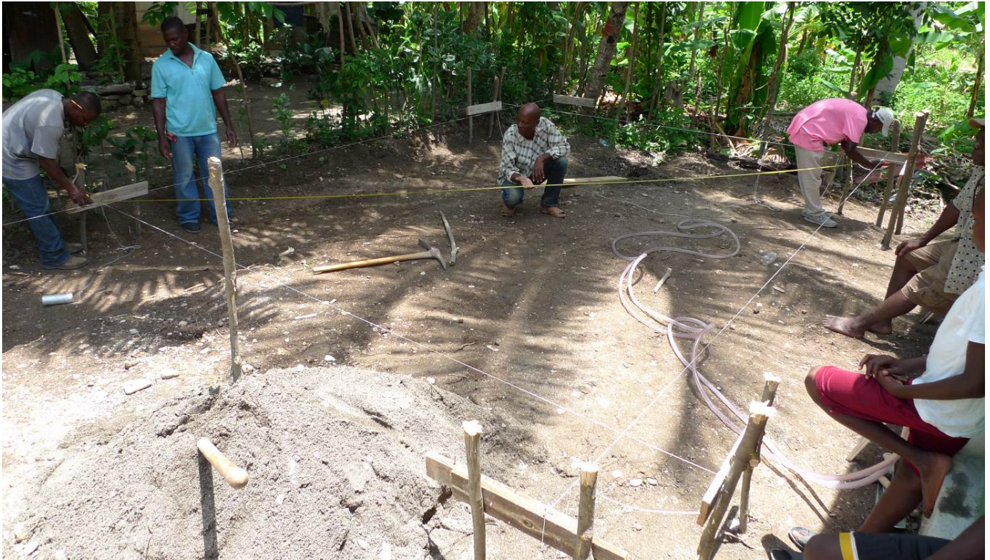
Vérification des diagonales
