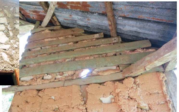
Maçonnerie de pierres « étranglée »
