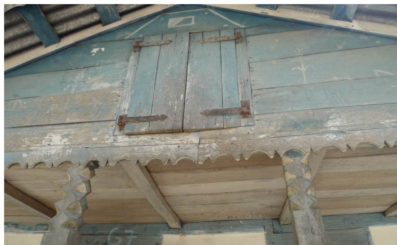
Habillage en planches et accès à la « galata »
