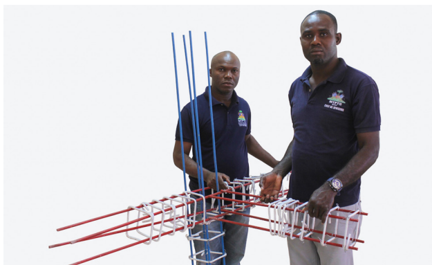
3. Rapprocher le deuxième chainage en laissant les étriers libres de mouvement pour faciliter l'introduction des pièces additionnelles
