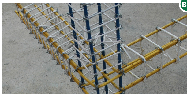
Pièce de connexion: 'L' dans un coin 'L'
