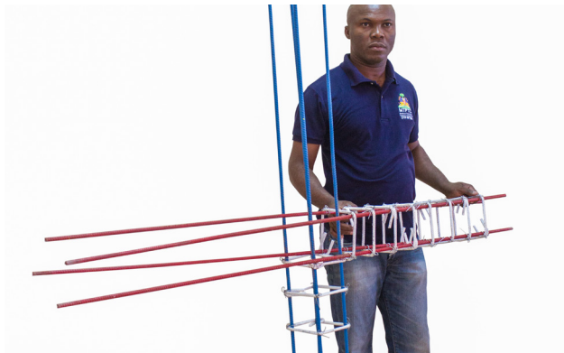
1. Placer le chainage horizontal sur le chainage vertical
