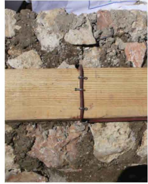
FIXATION SUPÉRIEURE REPLIÉ AUTOUR DE LA LISSE BASSE CLOUS 4" PLIÉS POUR MAINTENIR
