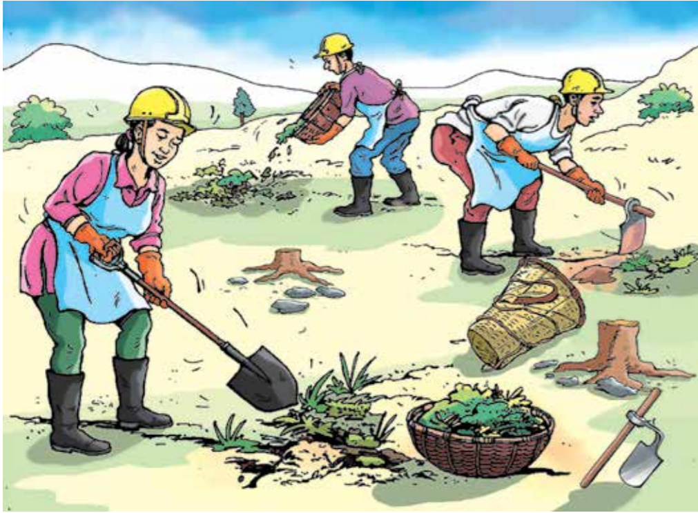
भवन निर्माण अघि स्थलको सरसफाई
