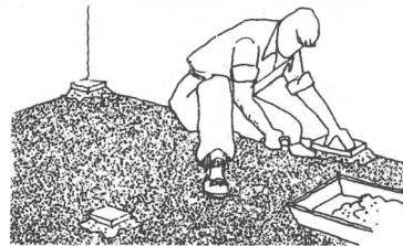
Worker placing markers Operario colocando las muestras que servirán de guía para colocar las piezas del piso terminado
