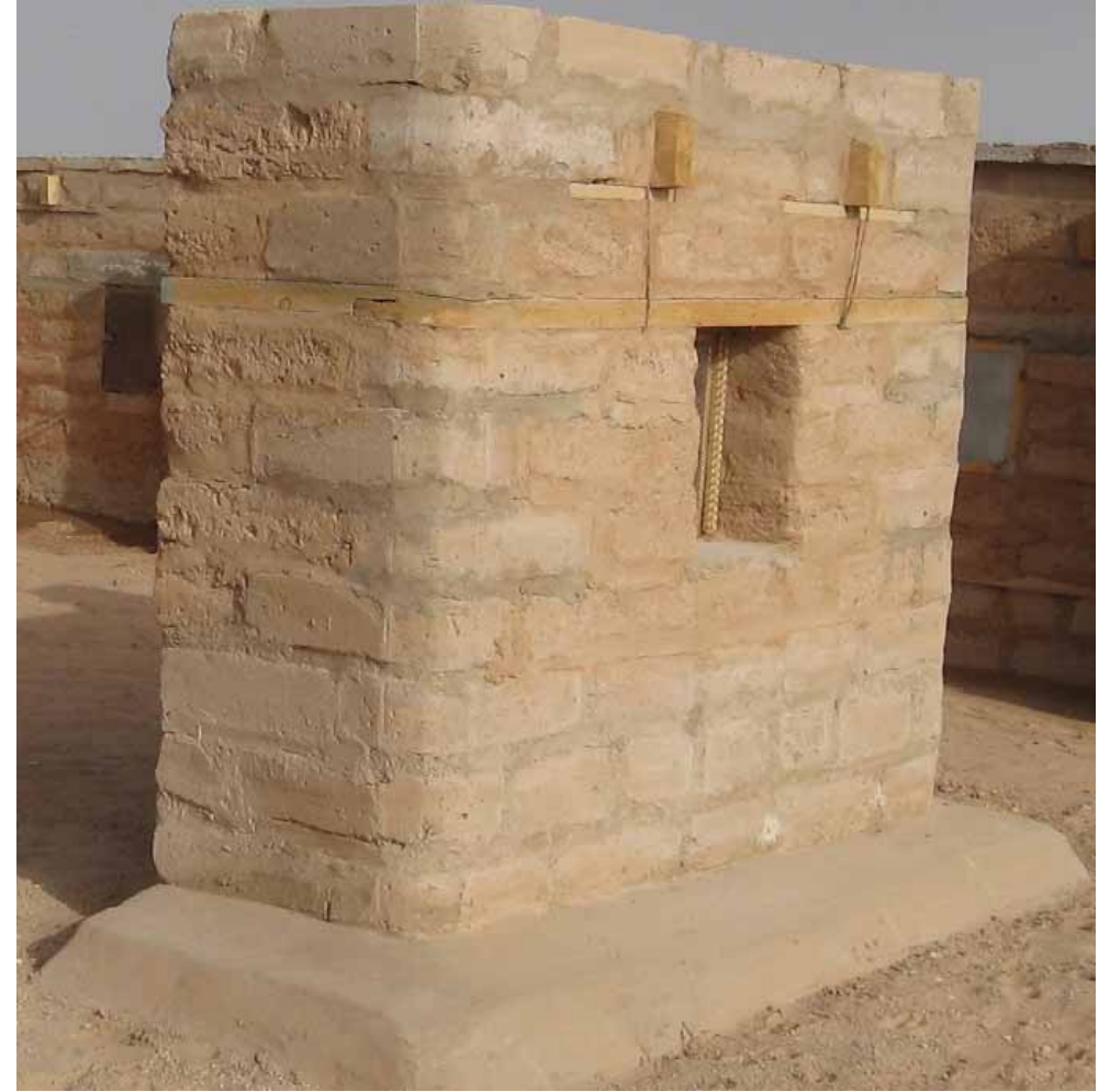
Camps Sahraouis ; angles du muret en adobe stabilisée arrondie
