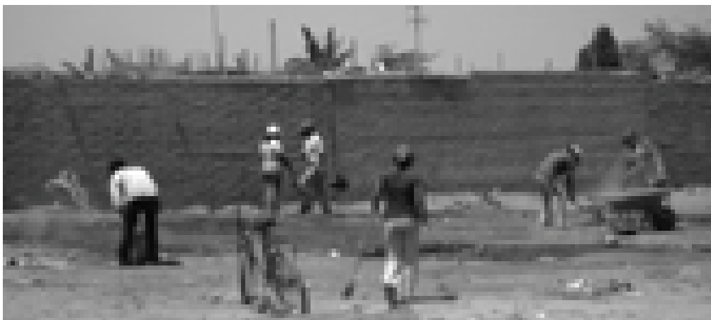
Limpieza de terreno
