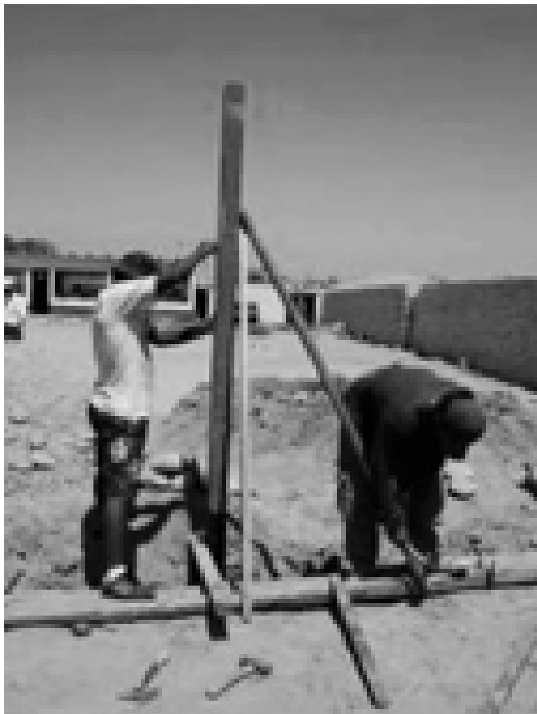
Columna aplomada y alineada, lista para ser empotrada en el cimiento
