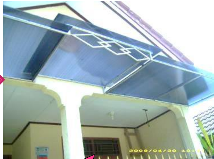
Penutup atap teras
