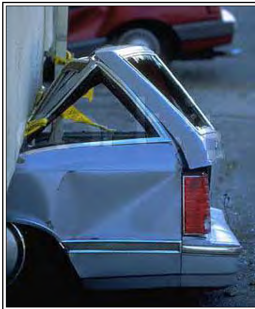
Colapso de edificación por piso débil
