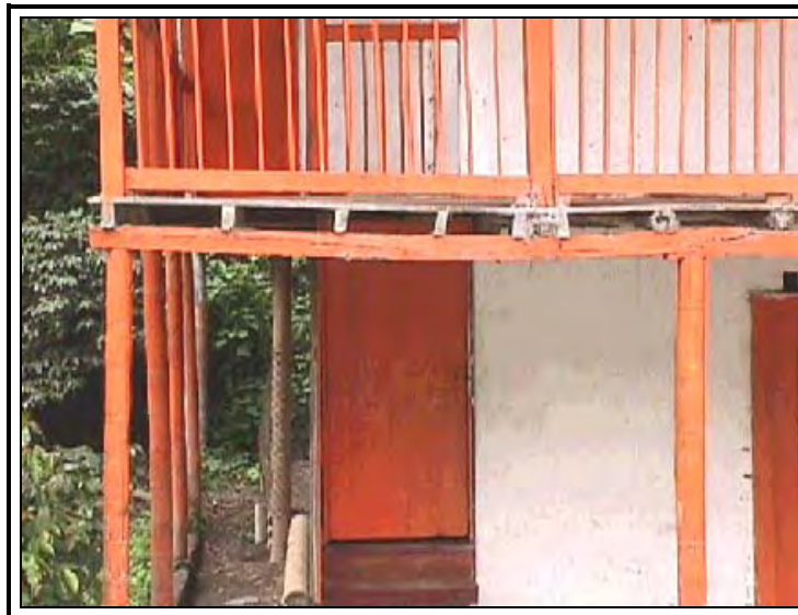
Flexión de elemento por longitud excesiva para el tamaño de la sección
