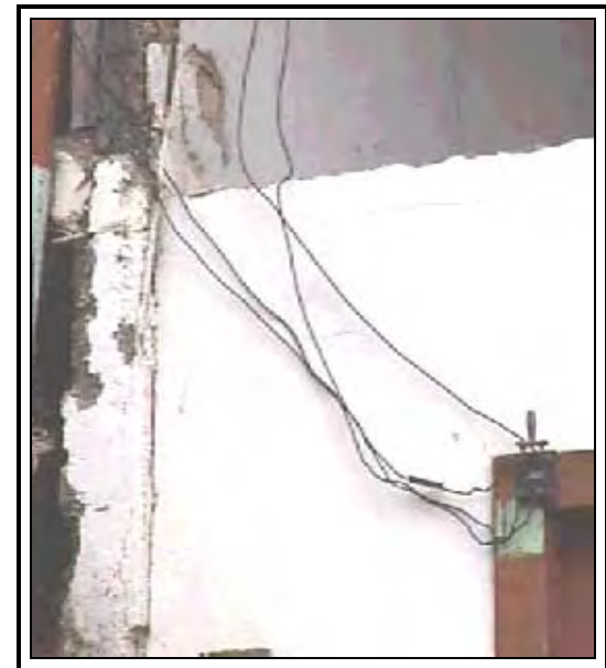
Cables a la vista, con empalmes inseguros.
