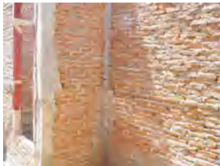
REKONSTRUKSI RUMAH PASCA GEMPA & TSUNAMI ACEH, 26 DESEMBER 2004 CONTOH MUTU BAHAN YANG RENDAH
