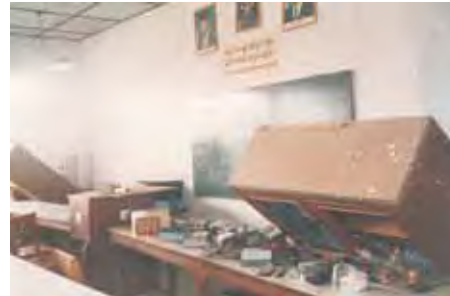
CONTOH KOMPONEN NON-STRUKTUR YANG MENGALAMI KERUSAKAN AKIBAT GEMPA.
