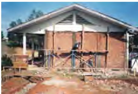
CONTOH PERBAIKAN DINDING ROBOH
