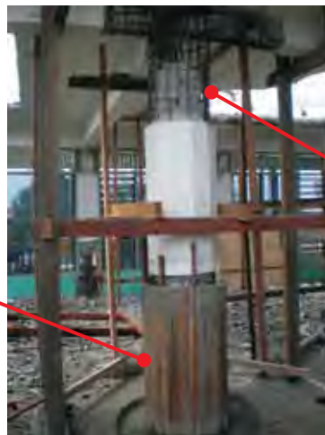
CONTOH PENGECORAN KOLOM BAGIAN ATAS DAN KOLOM BAGIAN BAWAH
