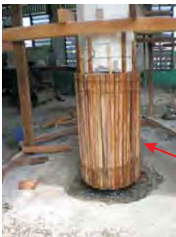
CONTOH PENGECORAN KOLOM BAGIAN ATAS DAN KOLOM BAGIAN BAWAH
