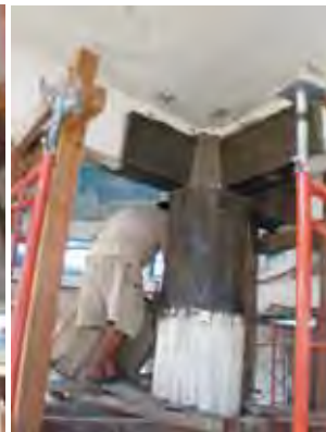
KOLOM SETELAH DICOR & BEKISTING DILEPAS
