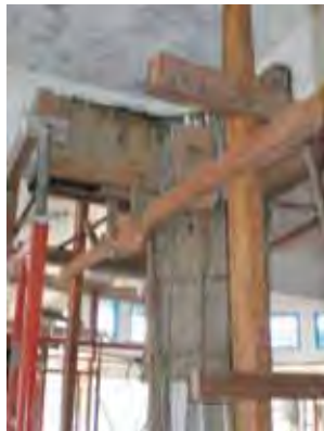
PEMASANGAN BEKISTING
