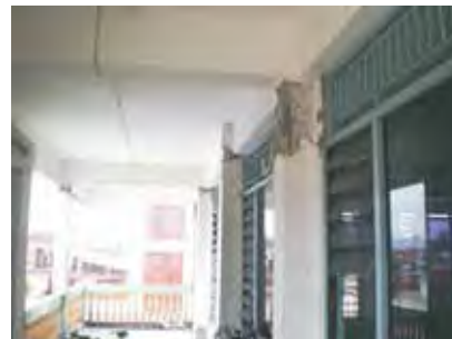
CONTOH KOLOM BAGIAN ATAS & KOLOM BAGIAN BAWAH YANG RUSAK
