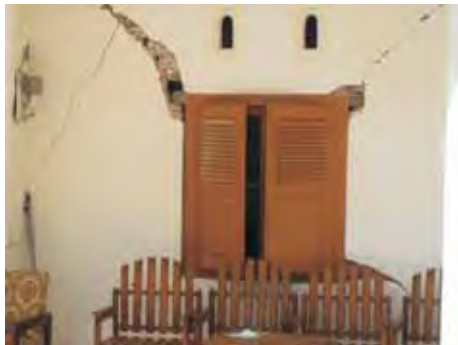
CONTOH DINDING RETAK DI SUDUT-SUDUT BUKAAN DAN RETAK DIAGONAL.
