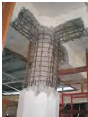
PELAKSANAAN PERBAIKAN, PENAMBAHAN TULANGAN & SENGKANG
