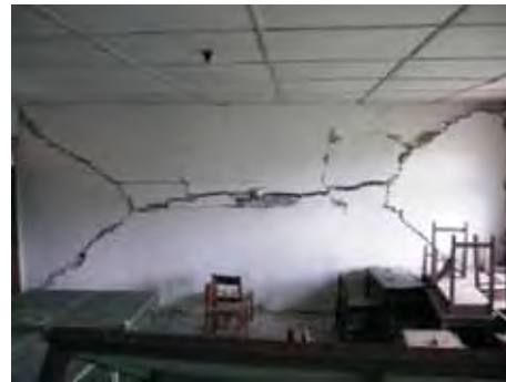
CONTOH DINDING RETAK DI SUDUT-SUDUT BUKAAN DAN RETAK DIAGONAL.
