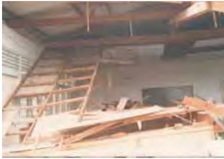
CONTOH RANGKA PLAFOND LEPAS DARI DUDUKANNYA
