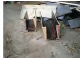
CONTOH BEKISTING YANG DIGUNAKAN UNTUK PENGECORAN
