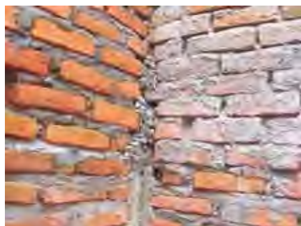
REKONSTRUKSI RUMAH PASCA GEMPA & TSUNAMI ACEH, 26 DESEMBER 2004 CONTOH MUTU BAHAN YANG RENDAH
