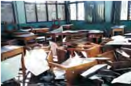
CONTOH KOMPONEN NON-STRUKTUR YANG MENGALAMI KERUSAKAN AKIBAT GEMPA.
