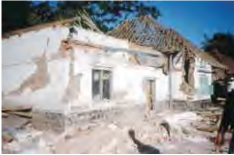
CONTOH RANGKA ATAP LEPAS DARI DUDUKANNYA
