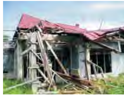
CONTOH RANGKA ATAP LEPAS DARI DUDUKANNYA
