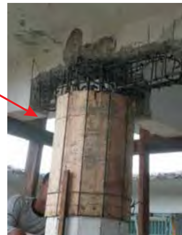
CONTOH PENGECORAN KOLOM BAGIAN ATAS DAN KOLOM BAGIAN BAWAH
