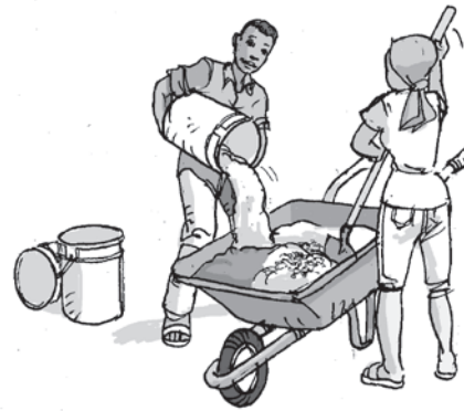
2. Mélanger les matériaux dans un récipient étanche et propre (Cf: brouette, en métal ou plastique)
