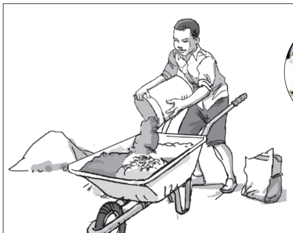
4. Préparer le mortier jusqu'à atteindre une consistance plastique
