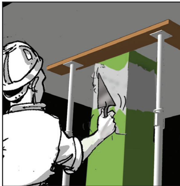
6. . Et appliquer l'enduit de ciment
