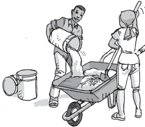
2. Mélanger les matériaux sur une surface sèche et propre ou dans un récipient sec et propre.
