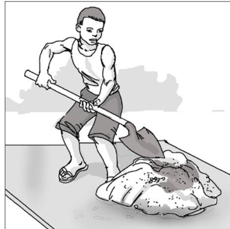
4. Mélanger les éléments sur un sol sec et propre
