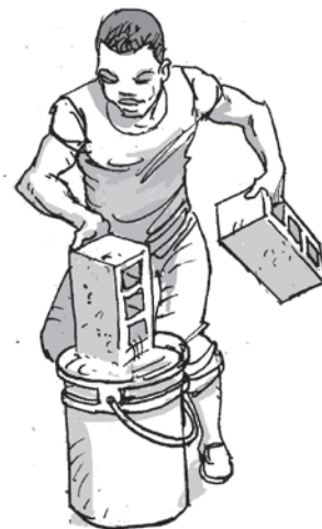
6. Humidifier les blocs avant de les poser.
