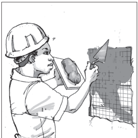
4-C. Appliquer de l'enduit
