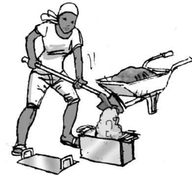
3. Verser le mélange obtenu dans le moule par couches
