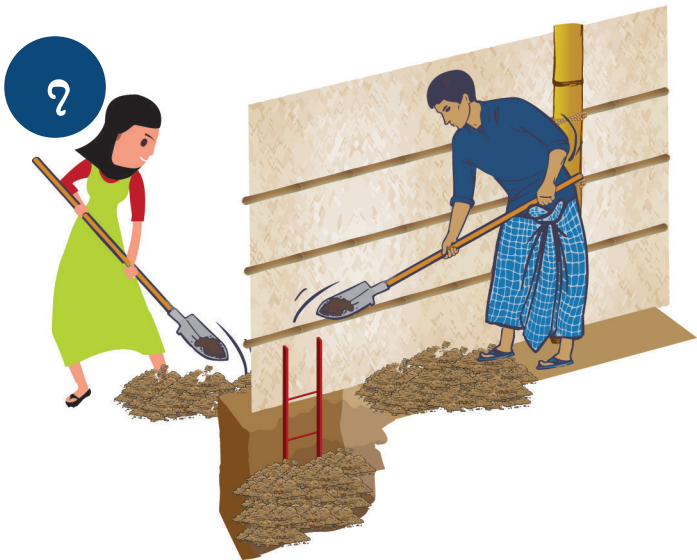
တွင်းကို ဖြည်းဖြည်းချင်း ပြန်ဖြည့်ပြီး အလွှာတိုင်း (အများဆုံး ၆ လက်မ ရှိတိုင်း) အတွင်း အပြင်မှ ခိုင်မြဲစွာ ဖိသိပ်ပါ။
