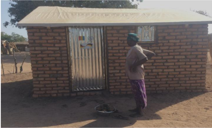
Photo d'un abri semi-durable construit par IOM dans le Sud
