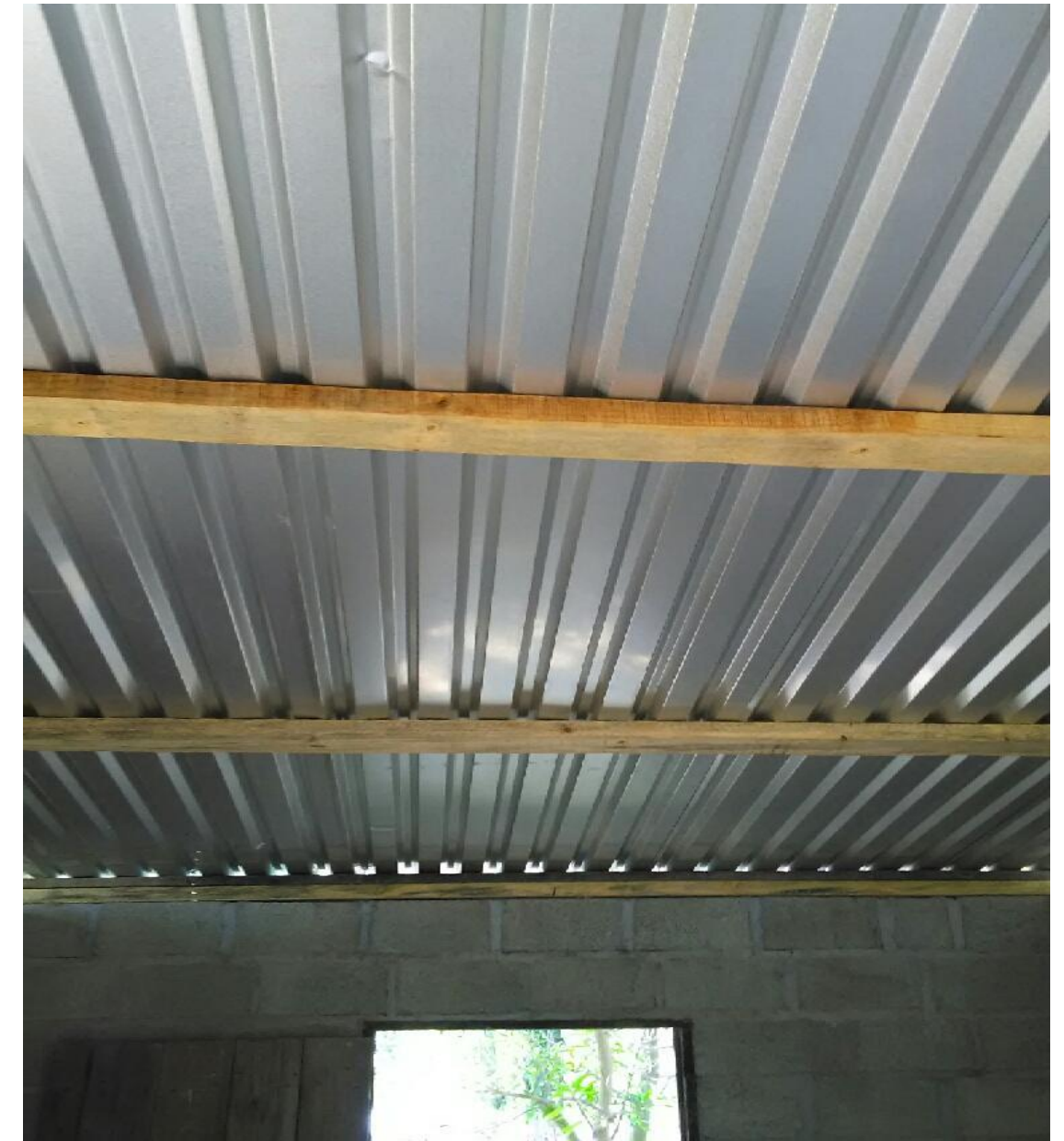
Reparación de techos realizada con el PTM
