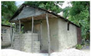
Rivière Froide : maison datant de plusieurs décennies avec structure en poteaux bois et clissage recouvert d'enduit ciment
