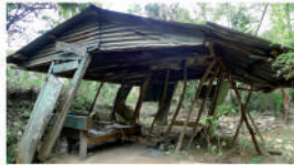
Angbeau : maison avec structure en bois et remplissage en panneaux clissés avec enduit en terre et badigeon à la chaux
