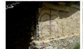
Façade arrière en clissage d'une maison avec poteaux en bois et remplissage en pierres
