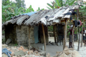
Angbeau : maison avec structure en bois et remplissage en panneaux clissés avec enduit en terre et badigeon à la chaux
