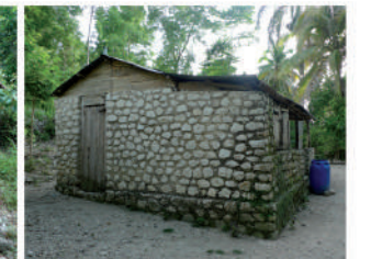
Structure en poteaux avec remplissage/parement en maçonnerie de pierres. La maçonnerie recouvre la structure en bois qui reste noyée à l'intérieur du mur.
