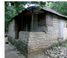
Structure en poteaux avec remplissage/parement en maçonnerie de pierres. La maçonnerie recouvre la structure en bois qui reste noyée à l'intérieur du mur.
