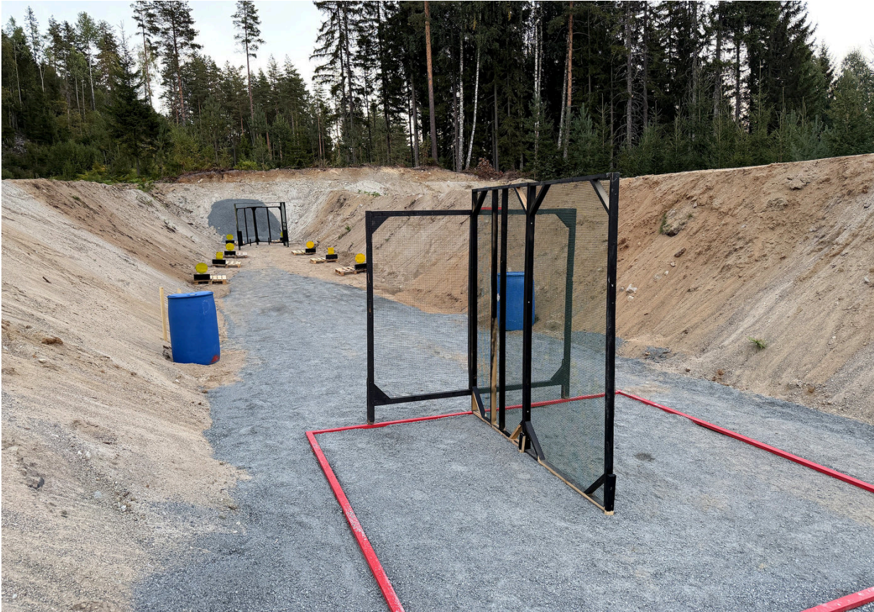
Foto av stagen slik den er bygget. Detaljer kan bli justert før matchen.
