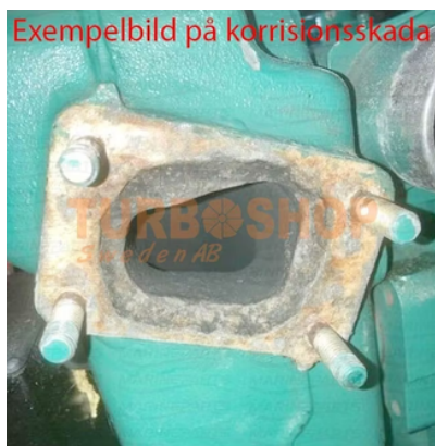
Exempel på korrosionsskada
