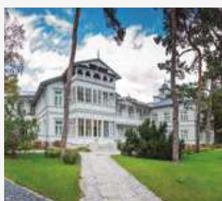
Gurewicz Spa Resort. Hotell- Restaurang - Spa. Otwock, Polen. PACi, VRF och Styrning.
