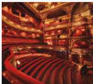
Belfast Grand Opera House. Offentlig byggnad. Belfast, Storbritannien. PACi, VRF och Styrning.
