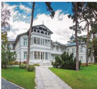
Gurewicz Spa Resort. Hotell - Restaurant - Spa. Otwock, Polen. PACi, VRF och Styrning.
