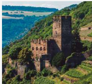
Gutenfels. Hotell. Kaub, Tyskland. Aquarea och Aquarea Smart Cloud.
