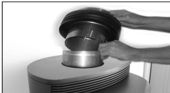
Montera först dit adaptorröret enligt bilden ovan. Täta med pannkitt. Placera sedan dit kopplingsstycket, var noggrann med att följa skorstensleverantörens anvisningar.
