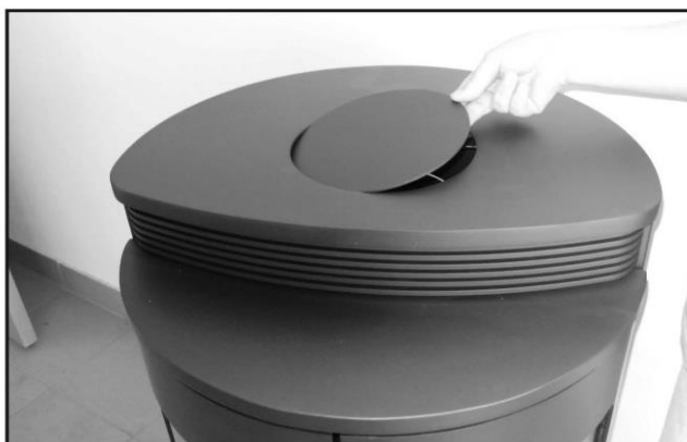
Täta locken noggrant med pannkitt på toppen.
