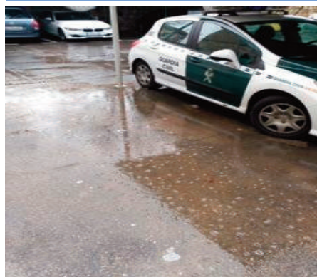
Inundación de aguas residuales en el puesto.
