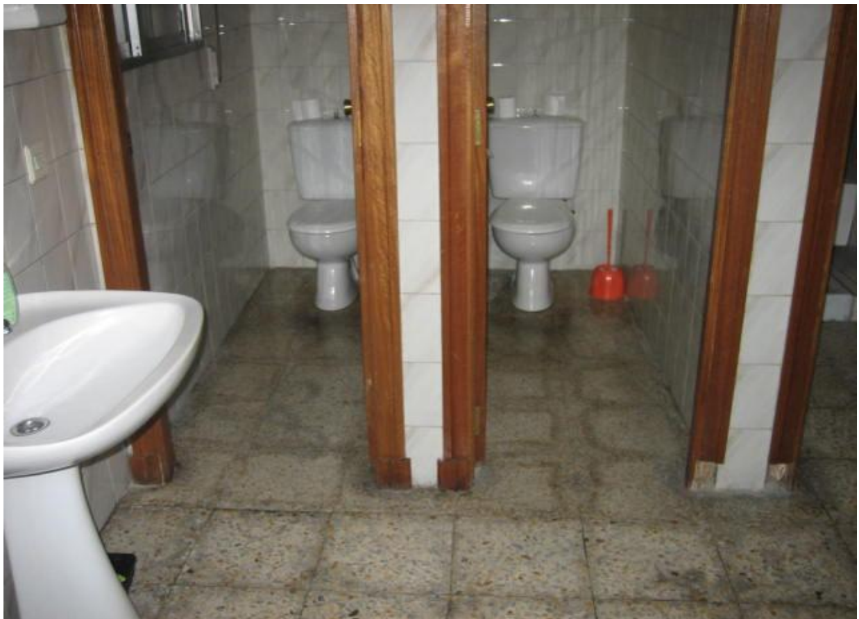
FOTO N° 7 INTERIOR DE LOS BAÑOS, LAVABO OPERATIVO Y RETRETES
